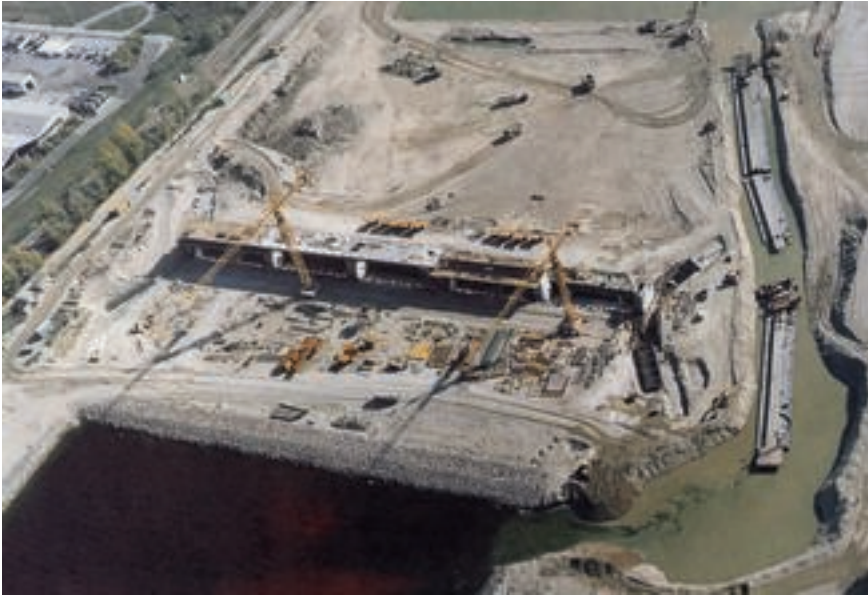
Baustelle des Wehres 2
