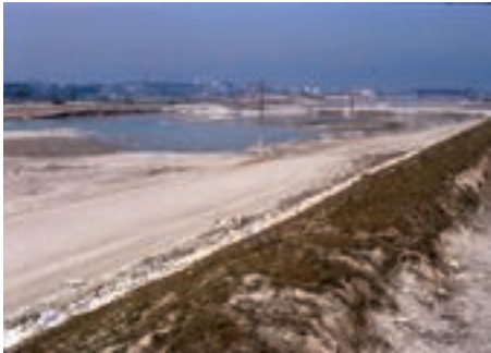
Bau der Donauinsel, Bereich Reichsbrücke, 1981
