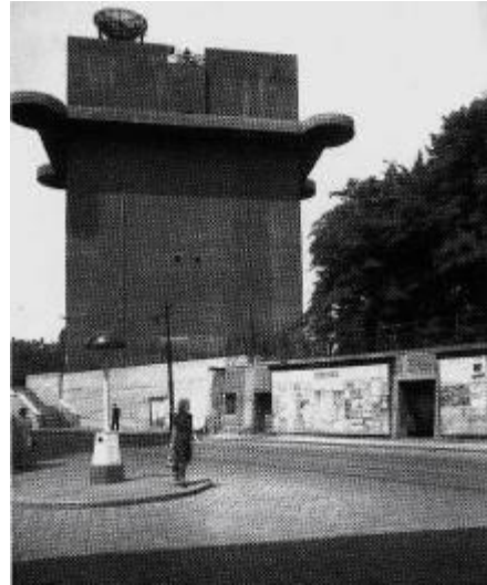
Der fertiggestellte Bunker mit „Würzburg Riese“
